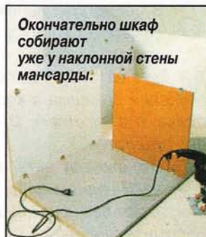
Материал для изготовления боковых стенок шкафа — плита МДФ толщиной 22 мм. Её можно покрывать лаком без предварительной грунтовки.
