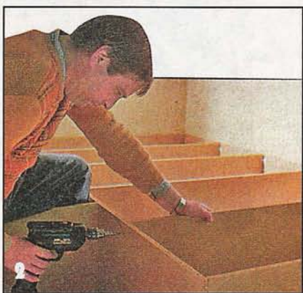
2 Установив через каждые 50 см продольные опоры, к ним крепят поперечные.
