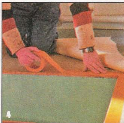
4 Выкроенные куски линолеума укладывают на двусторонней самоклеящейся ленте. Свисающие края ленты и линолеума аккуратно обрезают.
