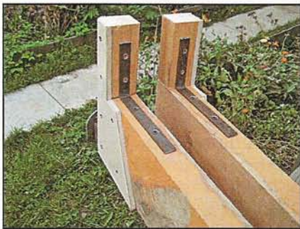
Боковые накладки вырезаны из 10-мм фанеры.
