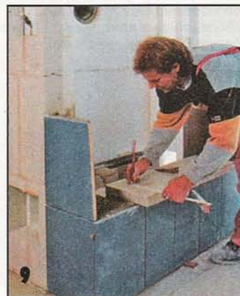
Чтобы обеспечить эффективную циркуляцию воздуха, топку следует установить как можно точнее.
