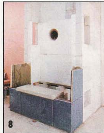
На нижние плитки кладут раствор, а на него — шамотные плиты, на которых потом будет стоять топка камина.
