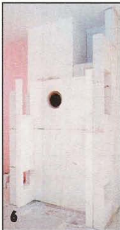
Возведя боковые стенки камина, их, а также тыльную часть обкладывают до верхней решётки специальными твёрдыми теплоизоляционными плитами. Плиты крепят термостойким клеем, который входит в комплект камина.
