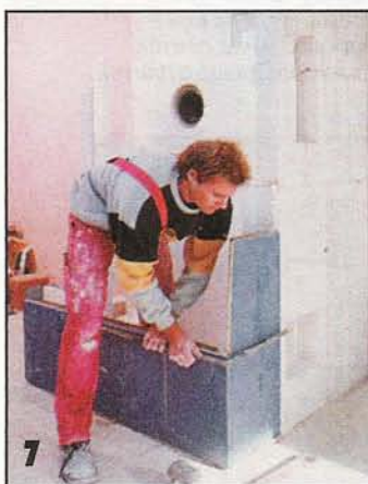
Затем стенки камина облицовывают поставляемыми вместе с камином кафельными плитками, располагая их с совмещением швов.
