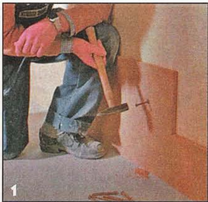
1 Двухступенчатые элементы рамы подиума монтируют на стене шурупами с дюбелями.
