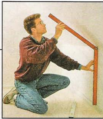
Угол наклона стены определяют с помощью самодельной малки — двух закруглённых с одного конца реек, соединённых болтом с барашковой гайкой. Таким способом угол можно измерить и перенести его непосредственно на боковые стенки шкафа.
