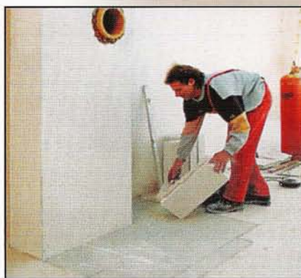
Сначала заливают фундамент под камин и вставляют шамотную трубу в дымовую, после чего можно возводить кладку из газобетонных блоков.
